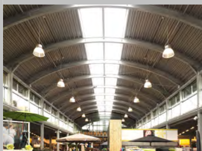
Vue de l'intérieur avec ouvrants de faitage en polycarbonate
