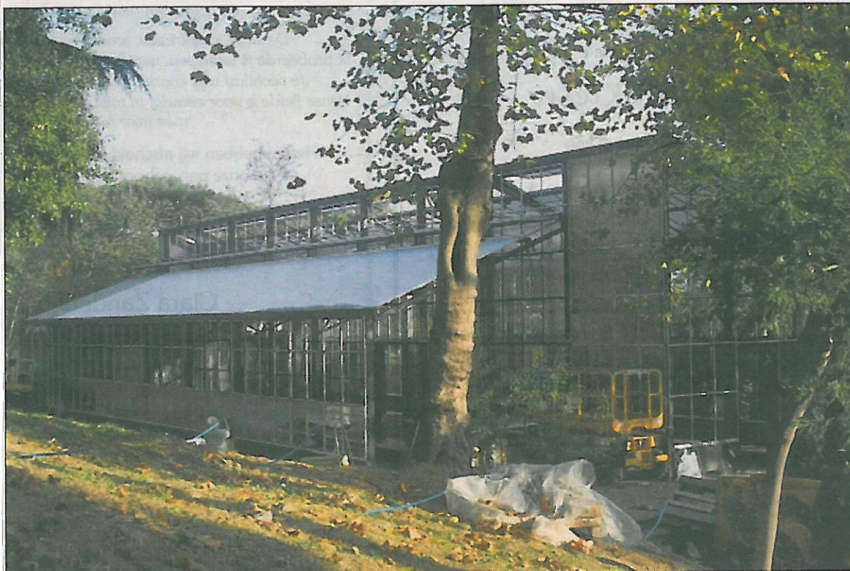
De oranjerie in aanbouw, achter het gebouw ligt de Bosporus.
